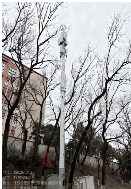
滨江西路隧道西
