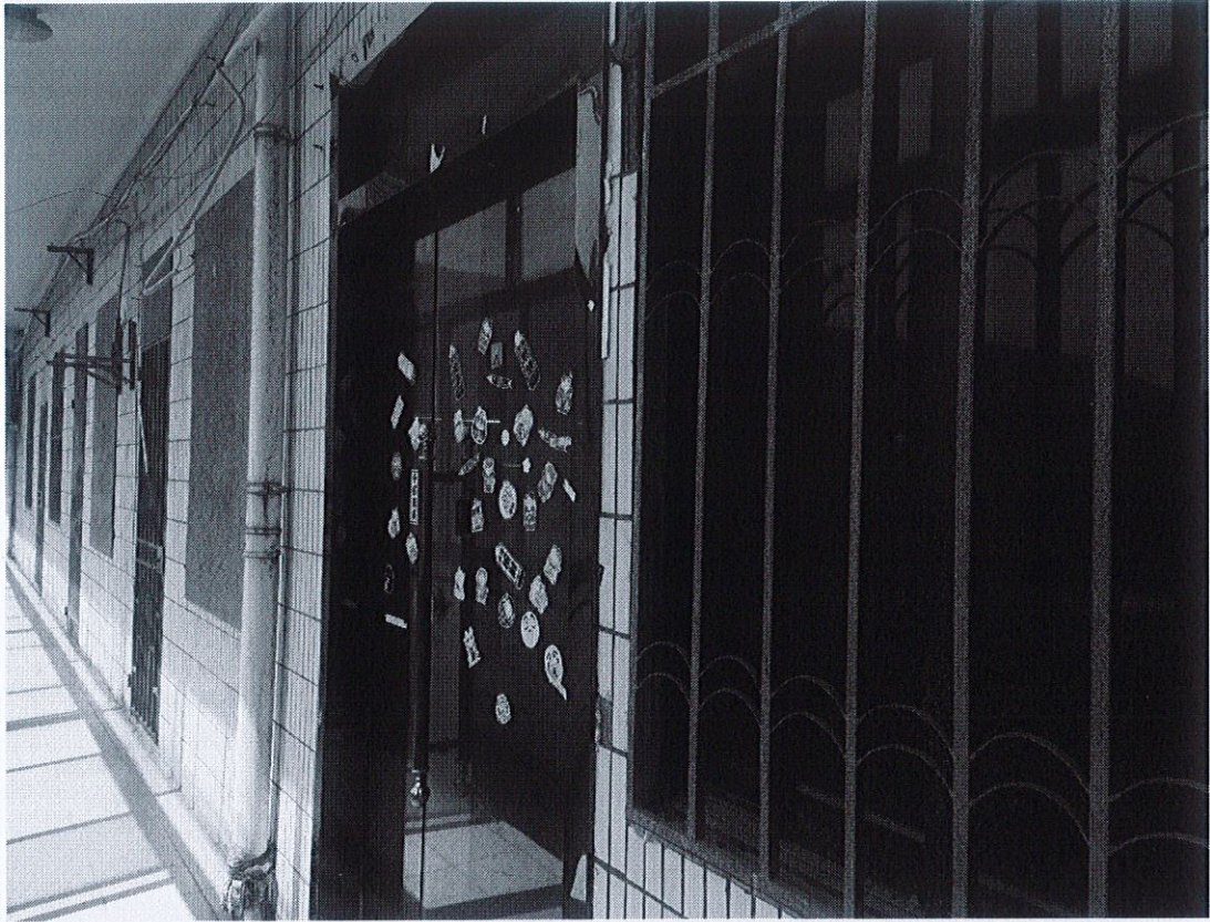
照 片（虹桥北路 73 号二楼 4 间）
